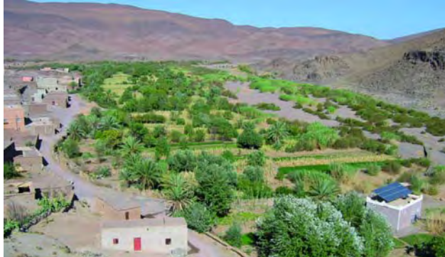
Sistema fotovoltaico en Boughrar.
